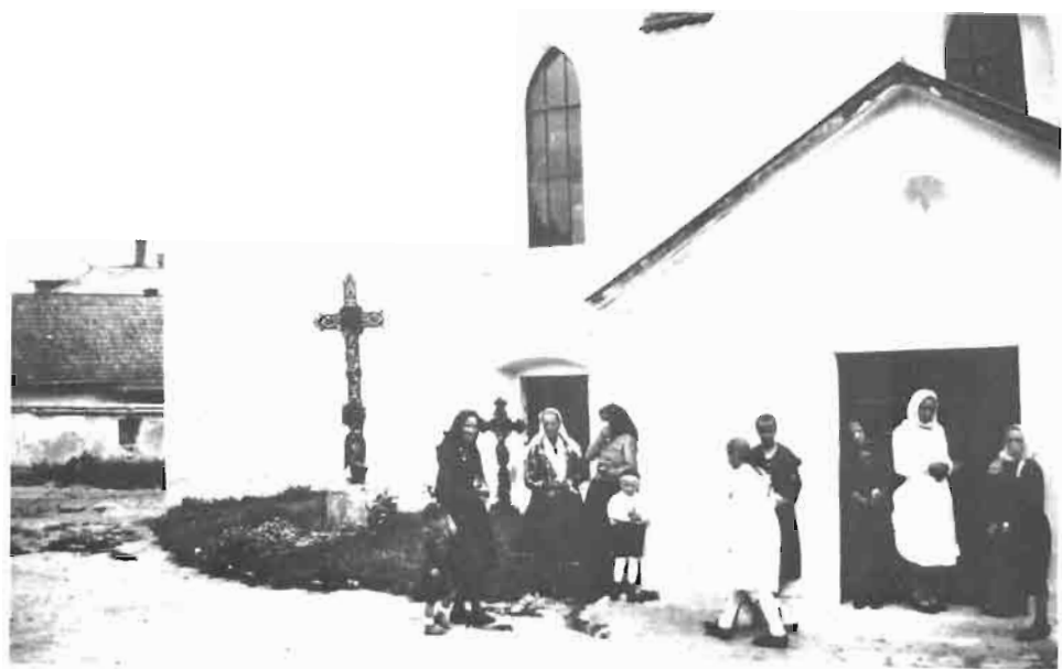
Kirche Südeingang, im Hintergrund Wehrmauer mit Nische (1934)
