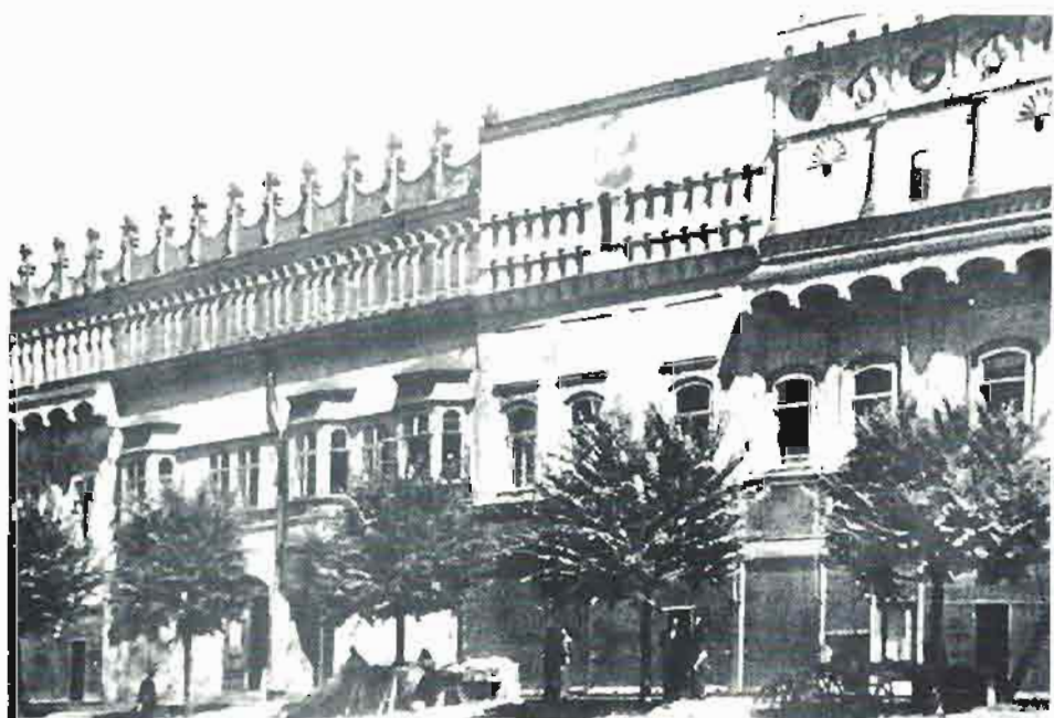
Häuserreihe an der Hauptstraße, in der Mitte das Rakoczihaus (Renaissance)
