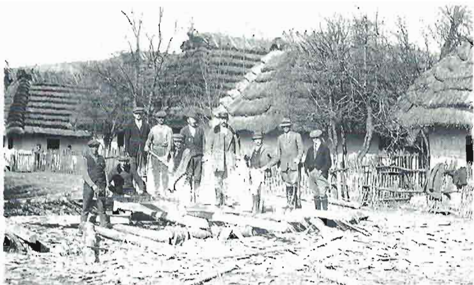
Wenn in einem slow. Nachbardorf ein Haus oder Stall gebaut wurde, so waren es Zimmerer aus Deutsch-Michalok, die den Dachstuhl erstellten. Auf dem Foto der Unternehmer Magerl Adolf (Lederkappe) mit seinen Männern
